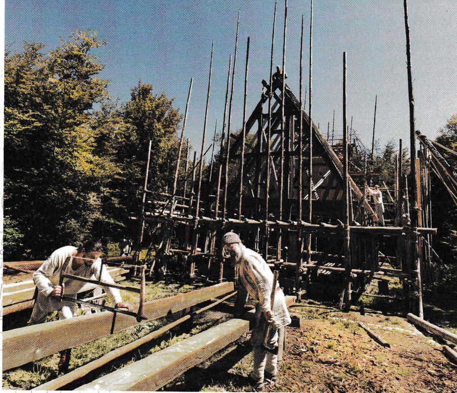
Zuerst wird eine Holzkirche errichtet: sechs Meter breit, zwölf Meter lang und zehn Meter hoch. Wie zu Zeiten Karls des Großen wird für die Gesamtanlage mit der steinernen Klosterkirche mit bis zu 80 Jahren Bauzeit gerechnet
