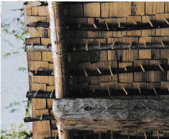
Die fertigen Schindeln werden mit ihren Holzstiften nach unten auf die Dachlatten gehängt. Eine Dämmung gab es noch nicht
